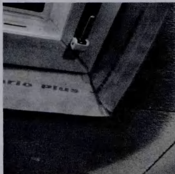
图 10 外窗防水隔气密封布
