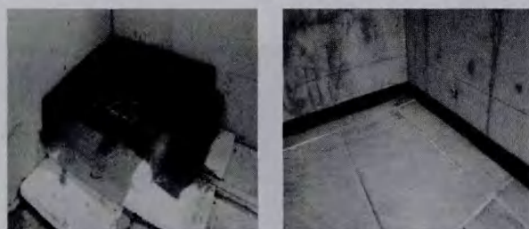
图 6 地板防水保温与隔声作法
