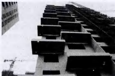
图 13 减少热桥的阳台构造设计
