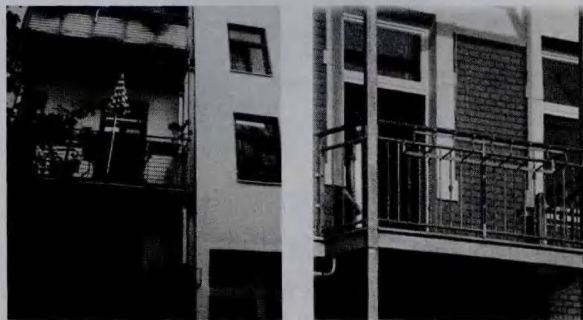
图 11 预制钢结构阳台
